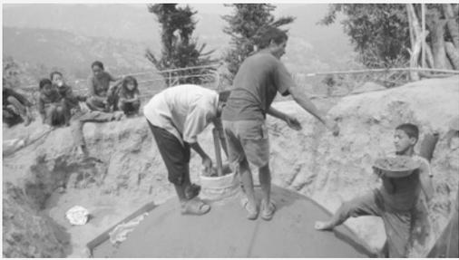
*Oben wird der Auslass der Gasleitung fixiert.*
