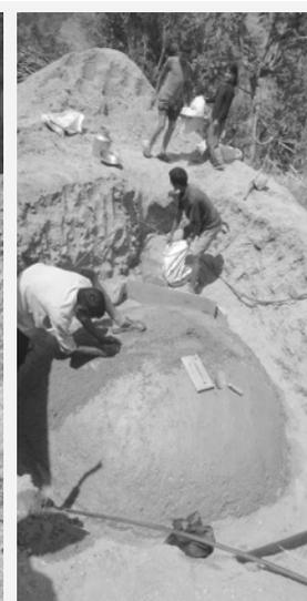
Dann wird die sieben Kubikmeter fassende Kuppel des Fermenters gemauert.
