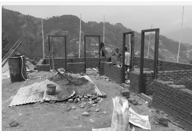
Hier wird die neue, erdbebensichere Krankenstation entstehen. Viele Patenfamilien packen auf der Baustelle kräftig mit an.
