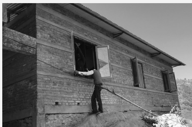
Das Gebäude ist fast fertig...
