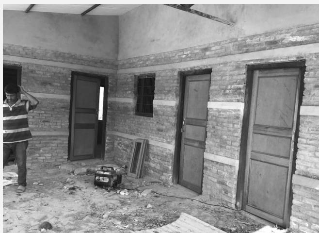
... jetzt kommt noch der Innenausbau.
