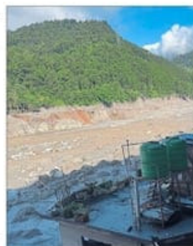
Eine Schneise der Verwüstung.
